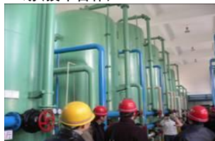
黑龙江省改善电热供应系统环境项目(日本国际协力银行贷款)
