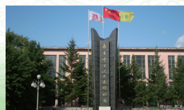
無償資金協力により完成した日中友好浄水場(1988)
