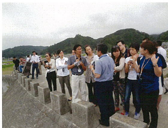
视察岩手县宫古市田老地区防潮堤
